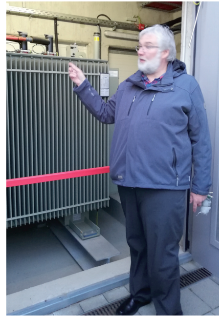
Frank Günther, Geschäftsführer der Versorgungsbetriebe Bordesholm, zeigt den Batteriespeicher, mit dem die Versorgung autark aus erneuerbaren Energien sichergestellt werden kann.
