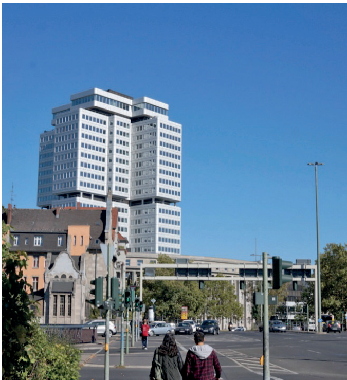
Der Campus Hohenzollerndamm der Deutschen Rentenversicherung Bund wird Jahre später fertig als geplant und kostet 45 Mio. Euro mehr.
