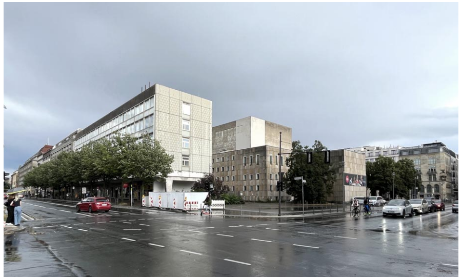
Blick auf die Ecke Unter den Linden/Glinkastraße. Im Zuge der Grundsanierung der Komischen Oper soll hier ein Erweiterungsbaun mit Dachterrasse, Shop, Café, neuen Büros und Probenräumen entstehen.
